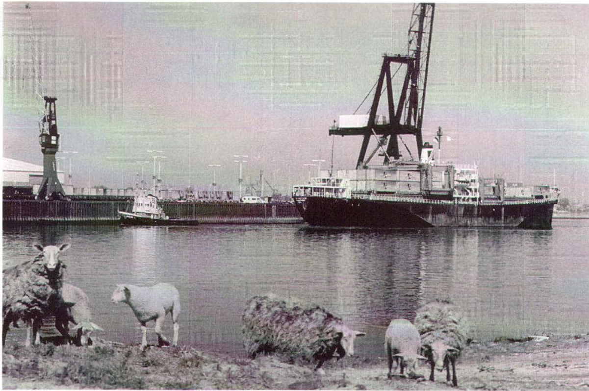
Der Neustädter Hafen nach Fertigstellung der Westkaje, um 1967
