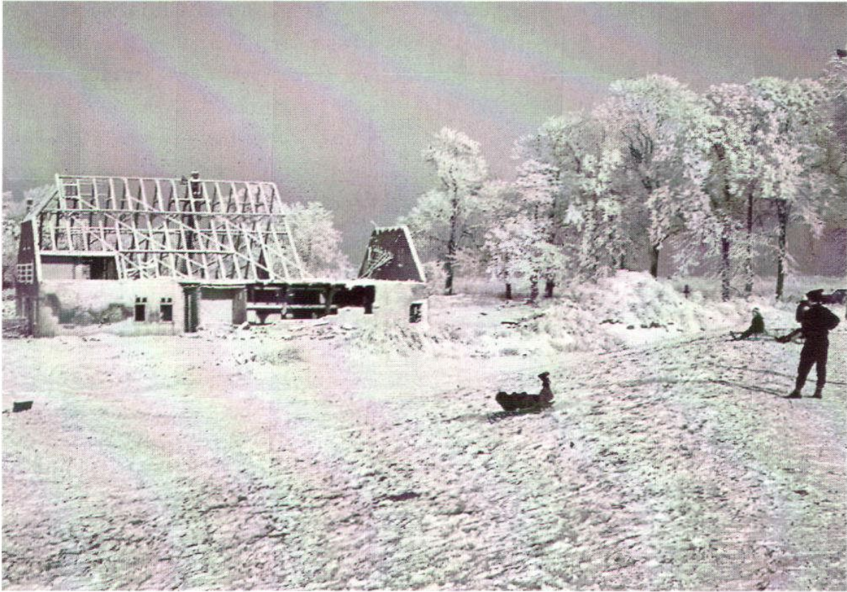
Abriss Hof Rose, Januar 1965
