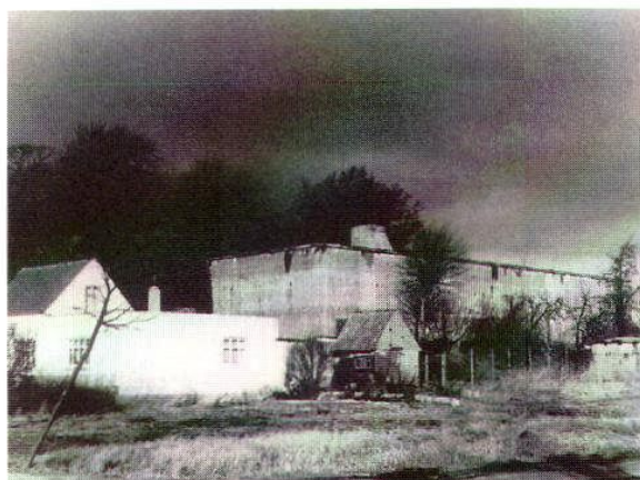
Hochbunker am Boyesweg
