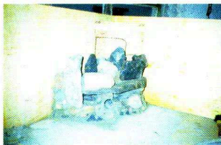
Die Spanplattenschalung für den Aufbau.
