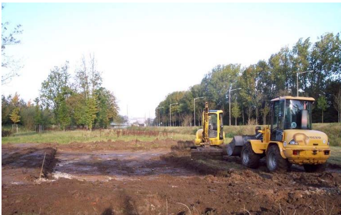
Hartplatz im Entstehen
