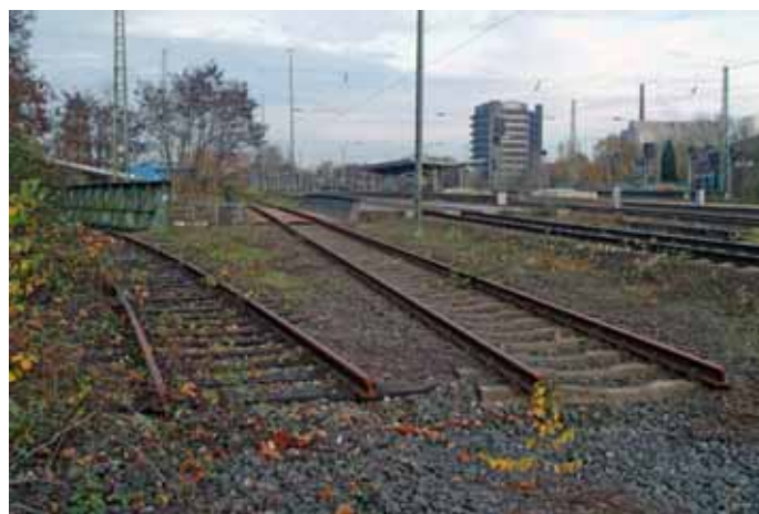
Ob mit mehr Wettbewerb auf der Schiene die Infrastruktur saniert werden kann ist fraglich. Fotos: Jörg Teichfischer
