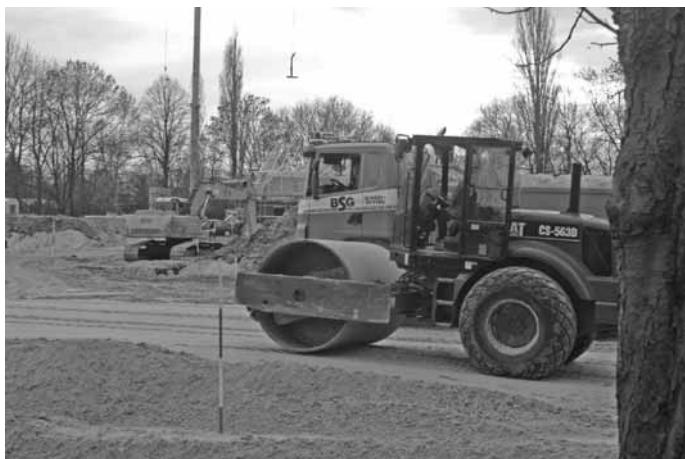
Baubeginn der Siedlung „Im Grünen Felde“.
